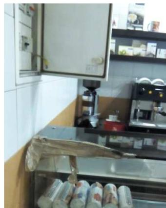
➤ Existência de cabos elétricos a atravessar zonas de circulação, por localização inadequada das tomadas elétricas destinadas a conectar as viaturas.
